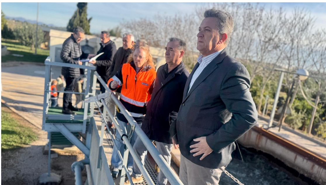
La ampliación de la depuradora de Riba-roja (Valencia) mejorará el saneamiento y aumentará la capacidad en un 85% LA RAZÓN
