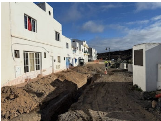
Obras del Consorcio del Agua de Lanzarote en el Ayuntamiento de Yaiza
